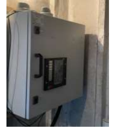
Монтаж шкафа связи
