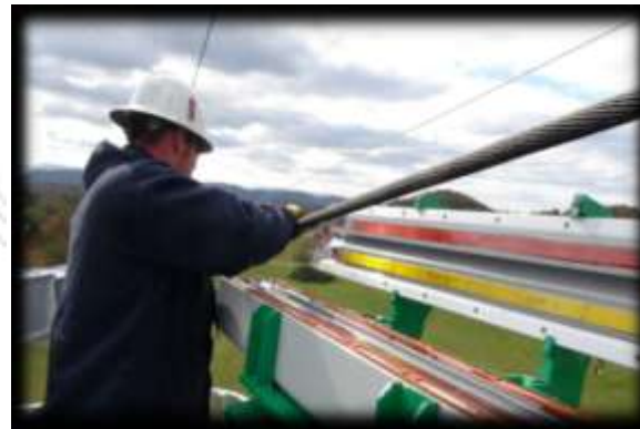
Монтаж МУПК на ВЛ
