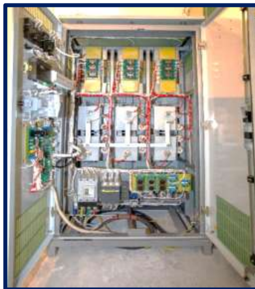
Опытно-промышленный образец полупроводникового регулятора реактивной мощности (ОПО ПРРМ) в ТПП 2873
