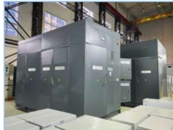
Габаритные размеры ПУРНТ (ДхШхВ), мм – 1000 x 1000 x 2900 в составе КТП (лицевая панель)
