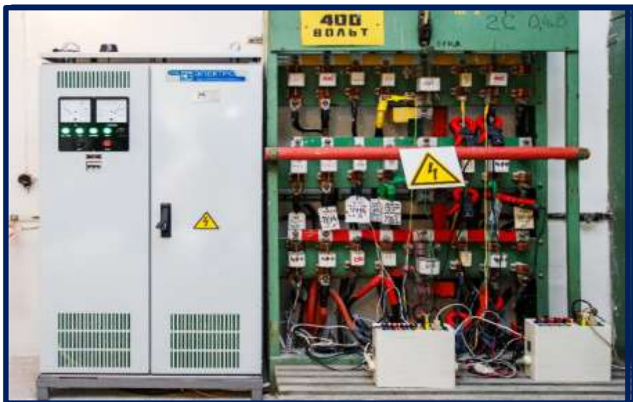
Опытно-промышленный образец полупроводникового регулятора реактивной мощности (ОПО ПРРМ) в ТПП 2873
